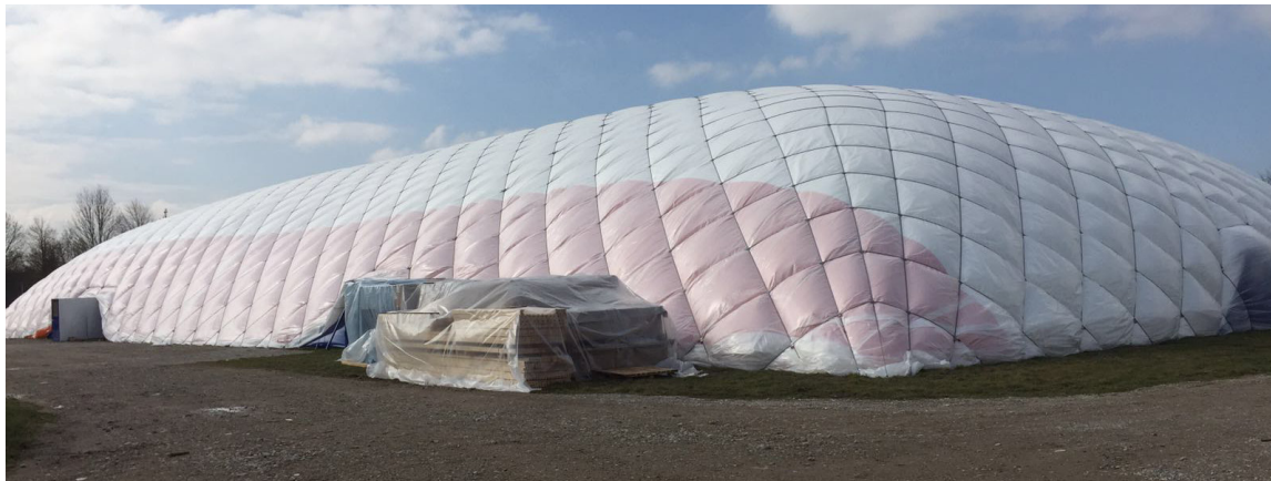
Endlich bezugsfertig: Die Traglufthalle am Neufahrner Sportgelände.
